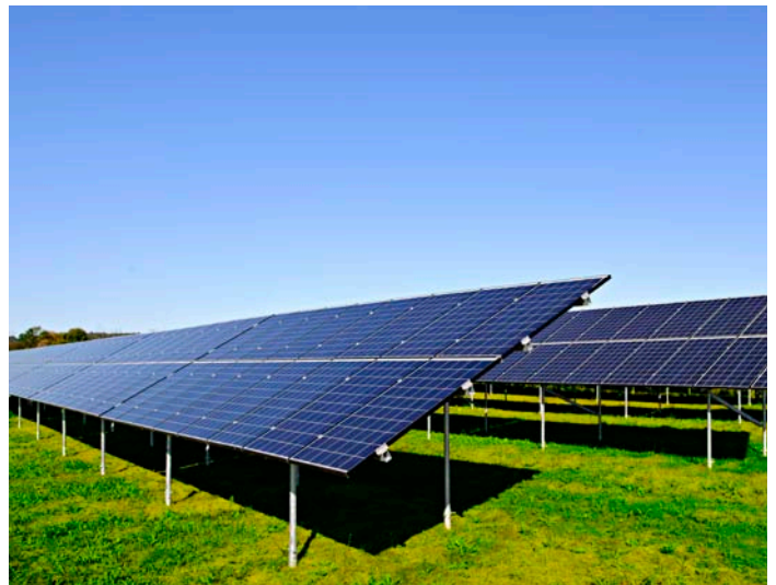
Fig. 3: Solaranlage nach der Reinigung
