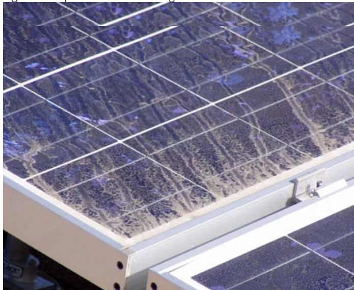
Fig. 2: Staubniederschlag auf Solarmodulen
